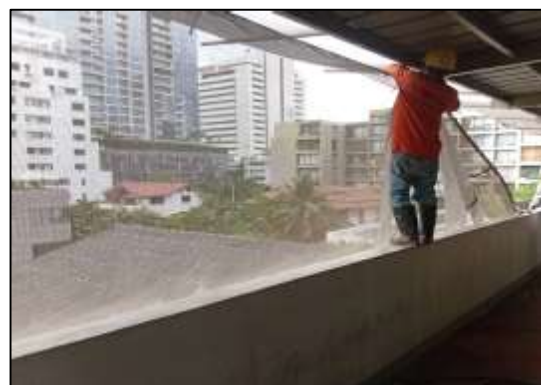
ภาพที่ 29 ตะแกรงป้องกันวัสดุจากการรื้อถอน
