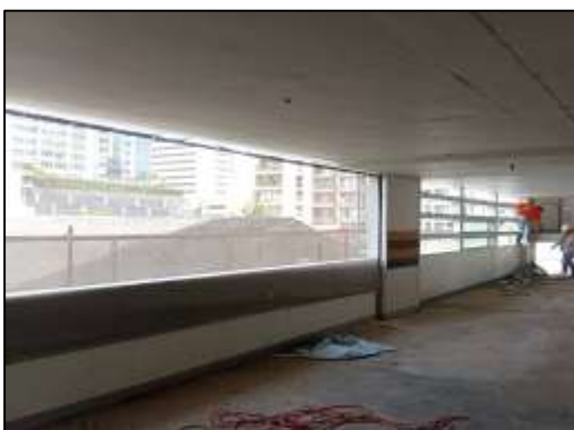
ภาพที่ 29 ตะแกรงป้องกันวัสดุจากการรื้อถอน
