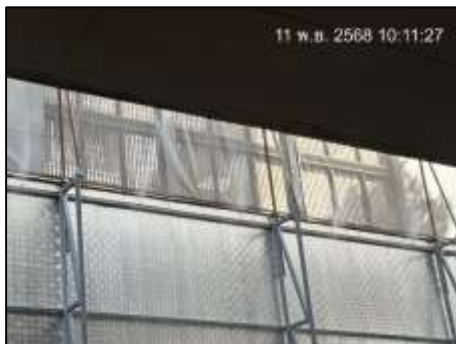
ภาพที่ 44 ติดตั้งม่านละอองน้ำบริเวณรั้ว Metal Sheet
